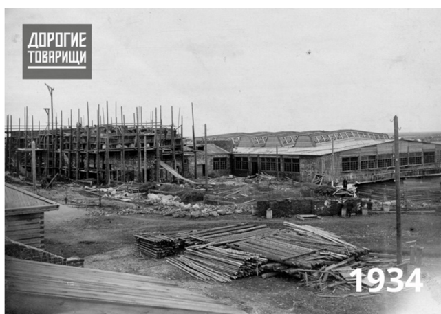
Строительство Республиканской типографии. 1934 год (фото с сайта «Дорогие товарищи»)
